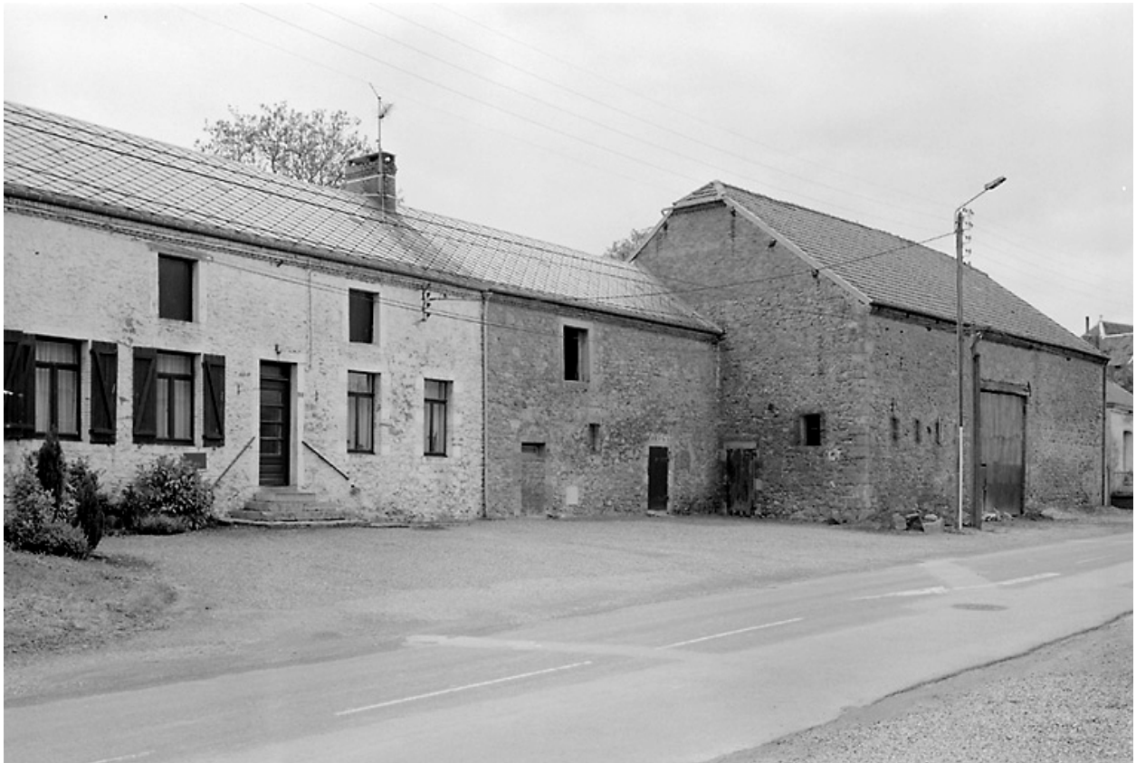
Vue de la ferme située 7 rue d'Avesnes.
