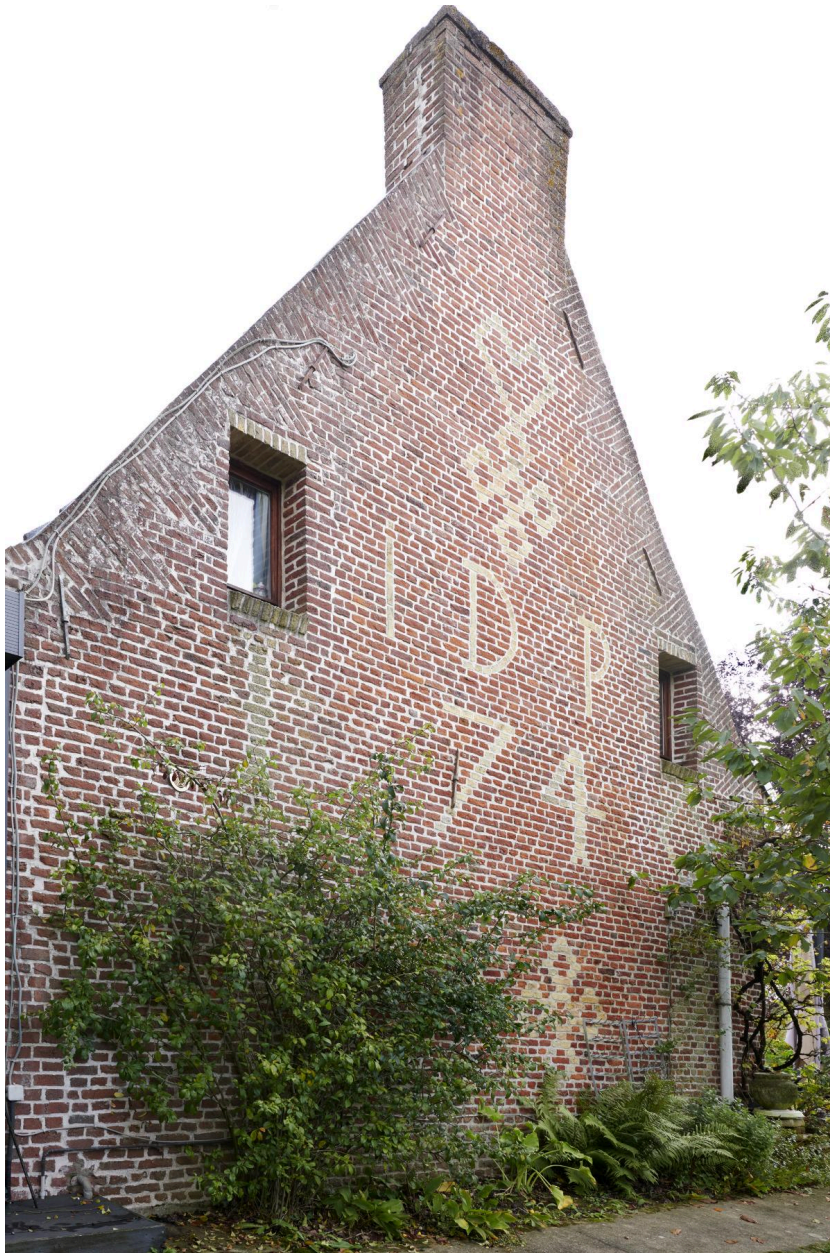
Détail du pignon ouest.
