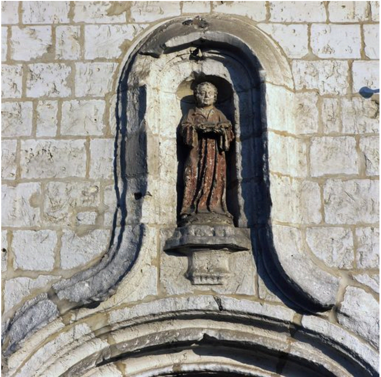
Vue de détail sur la niche surmontant la porte sud.
