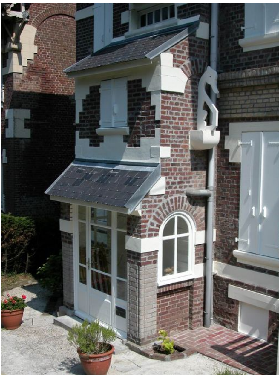
Détail du porche d'entrée.
