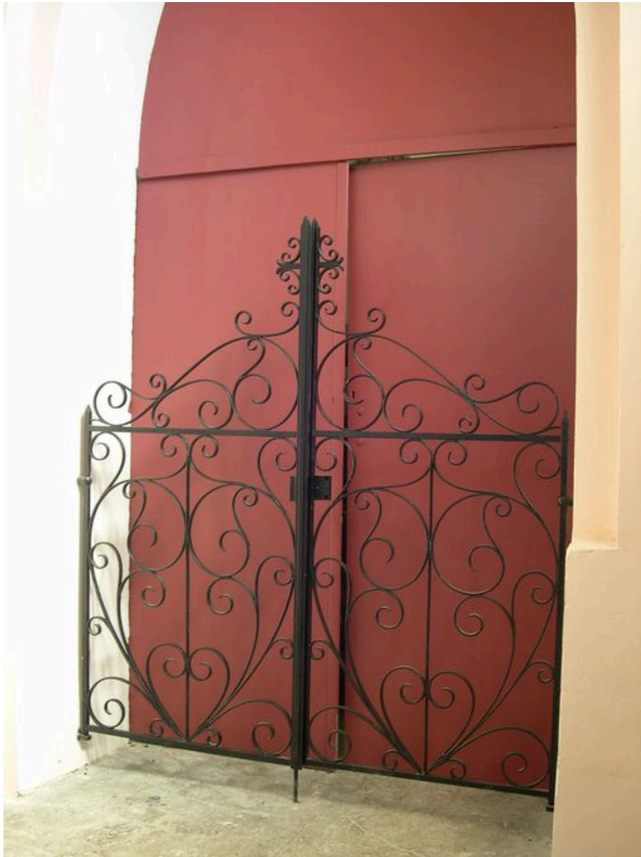
Grille fermant les pièces attenantes au vestibule.
