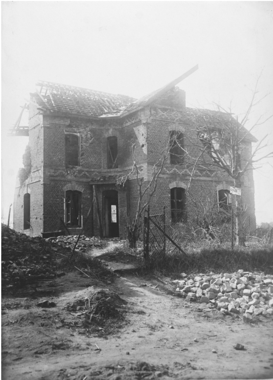
Les logements de contremaître, vers 1919 (AD Aisne).
