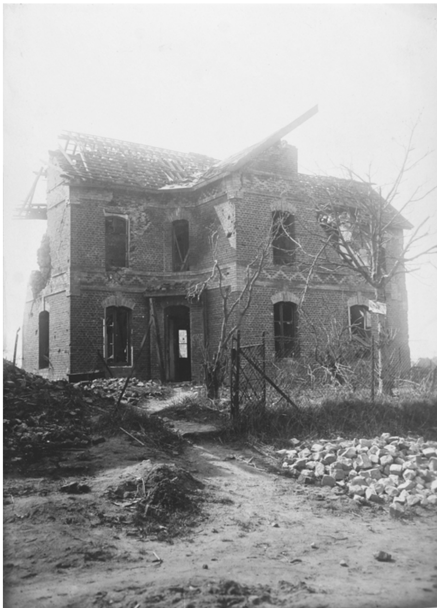
Les logements de contremaître, vers 1919 (AD Aisne).
