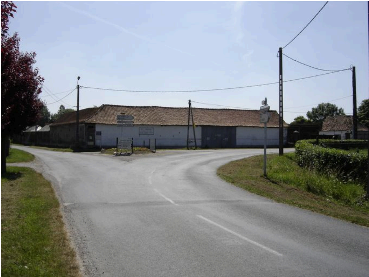
Vue de la grange depuis la rue des Forges.
