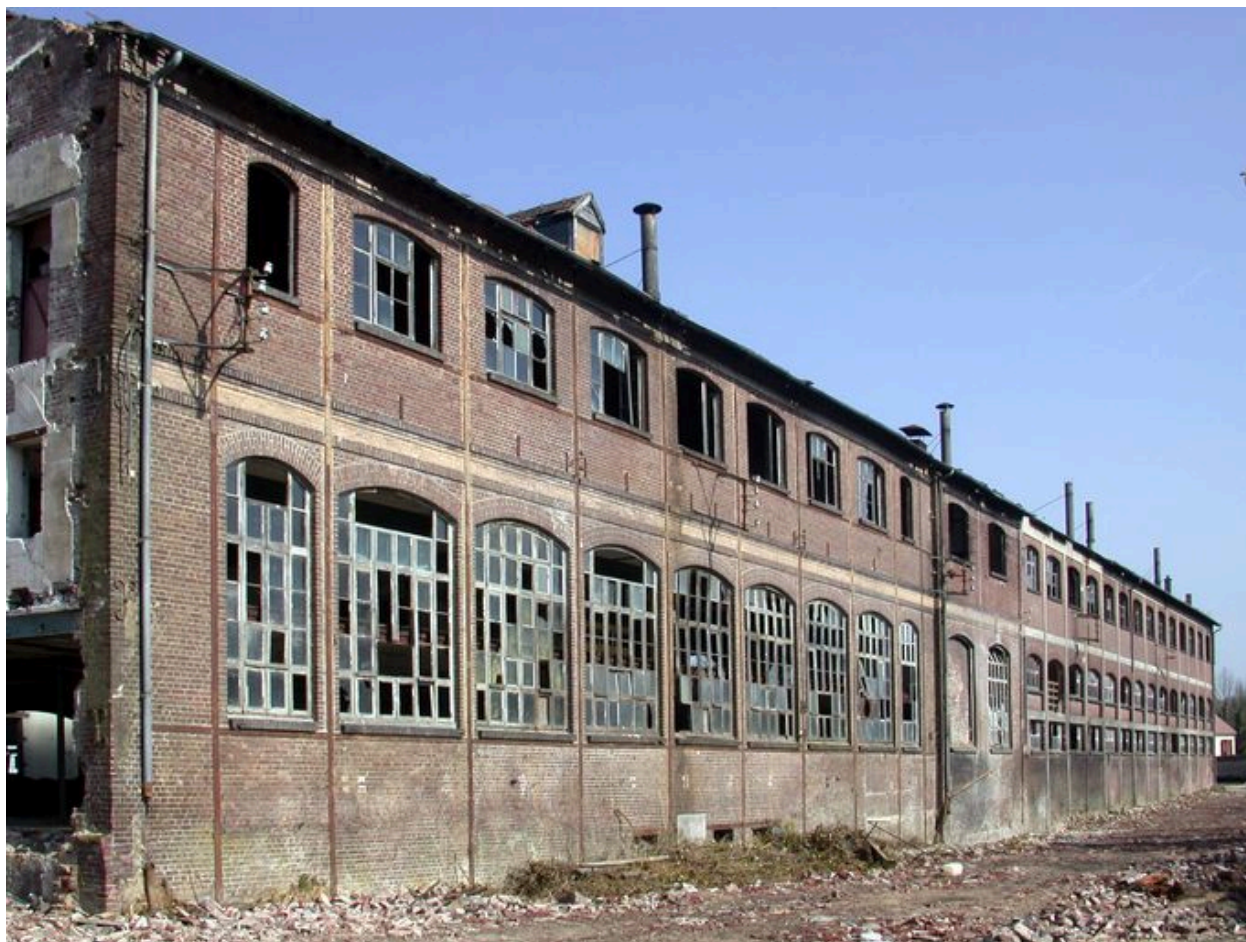
Façade du grand atelier de montage, vue d'ensemble.
