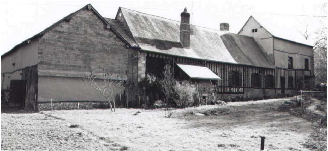
Vue d'ensemble postérieure du moulin et de son habitation.
