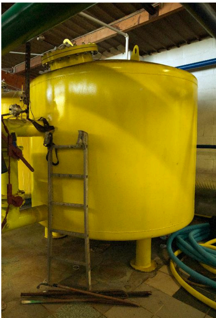
Local technique : cuve de filtration.
