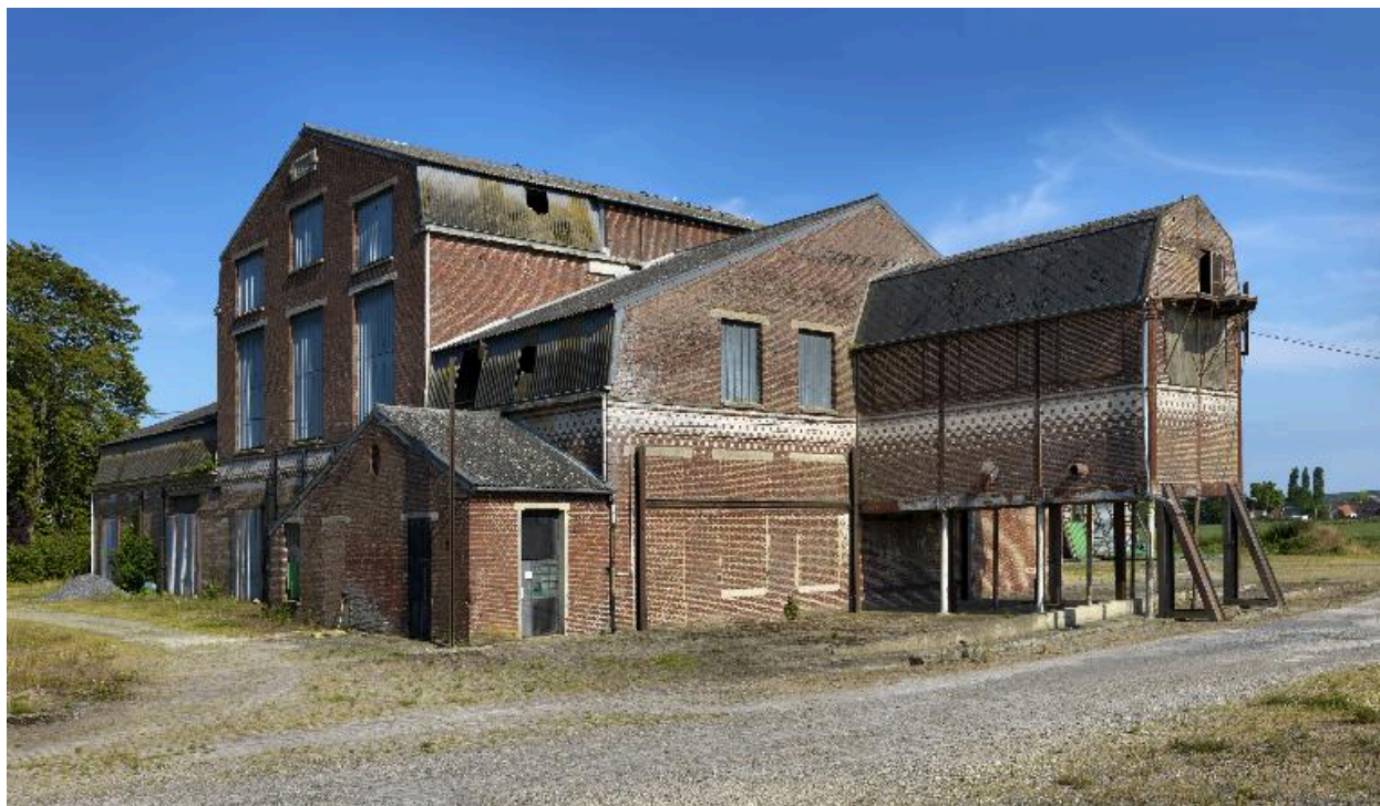
Vue d'ensemble de l'atelier fabrication de la râperie, vue de trois-quarts.
