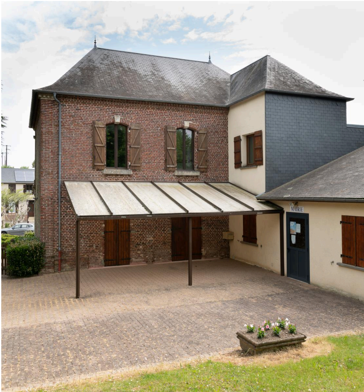
Mairie (ancien presbytère), vue depuis le sud-ouest.
