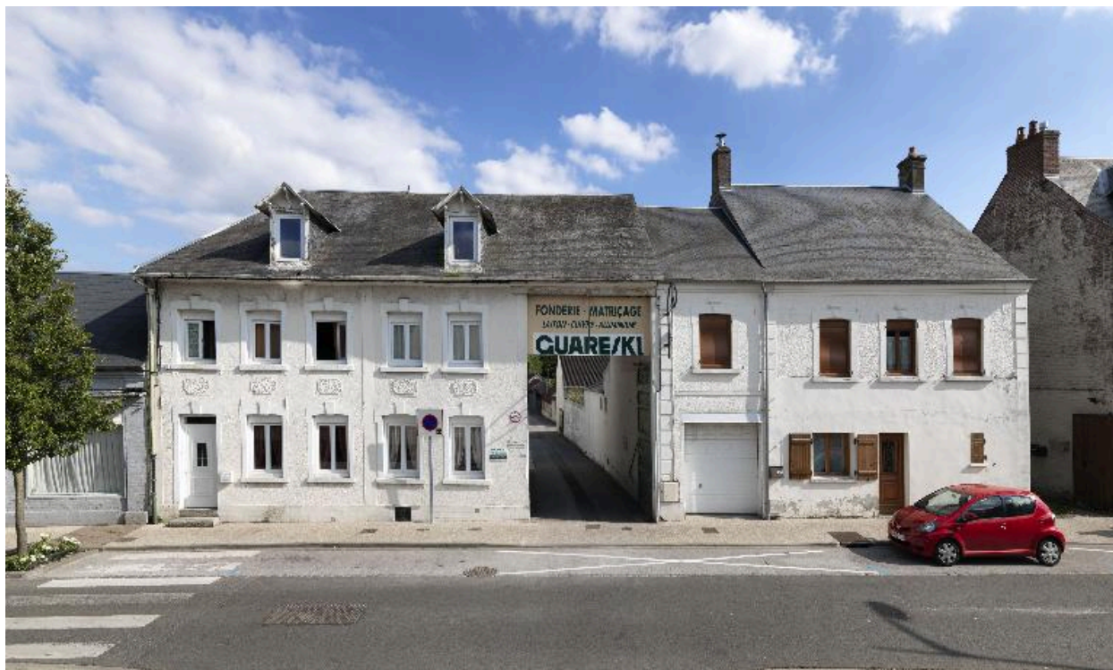
Vue générale sur rue.
