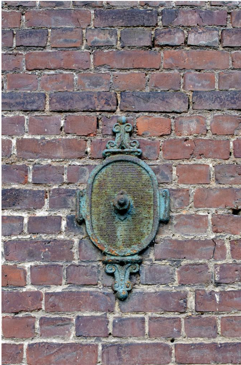
Fer d'ancrage sur l'élévation sud-est.
