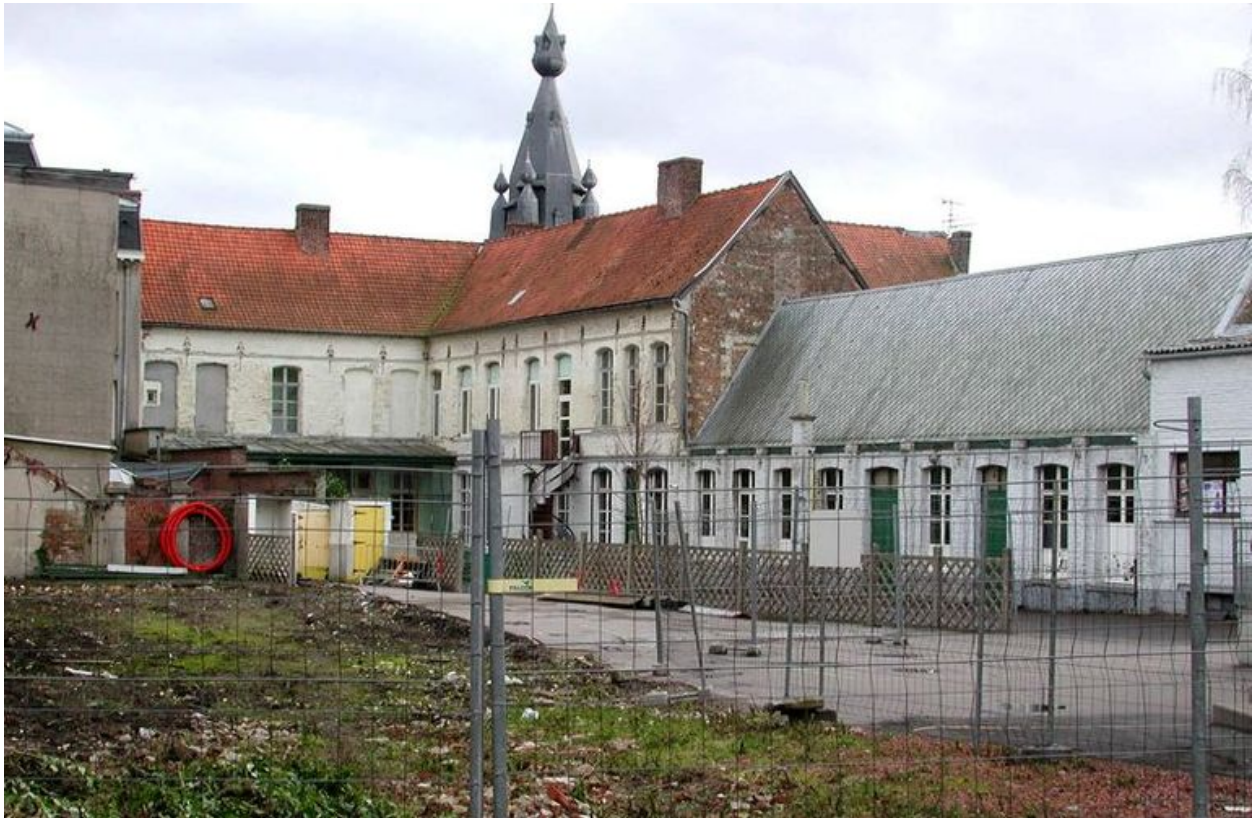
Vue depuis la rue Neuve : façade arrière, aile en retour, aile de la cantine, cour.
