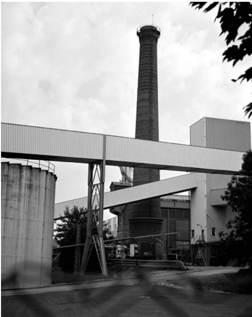
Vue de la cheminée d'usine.
