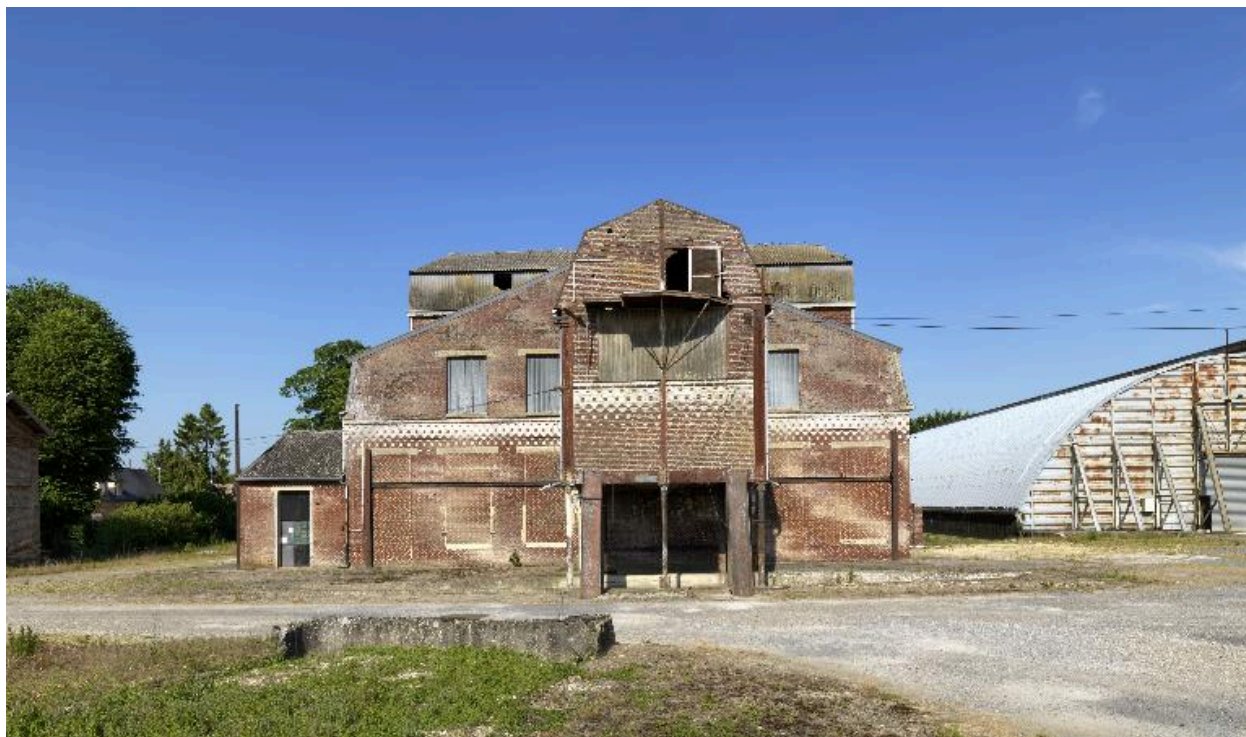
Atelier de fabrication de la râperie, vue de face.
