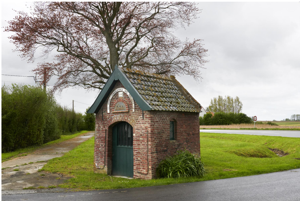
Vue générale depuis l'est.
