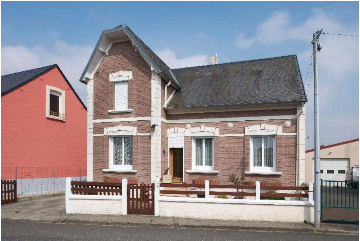
Logement patronal, 45 rue Emile-Zola.
