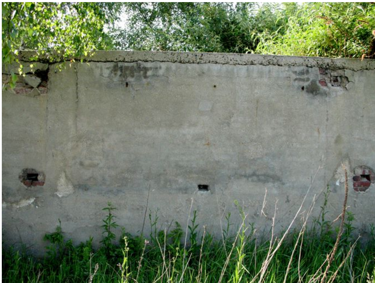
Mur de clôture de l'usine en brique enduite.
