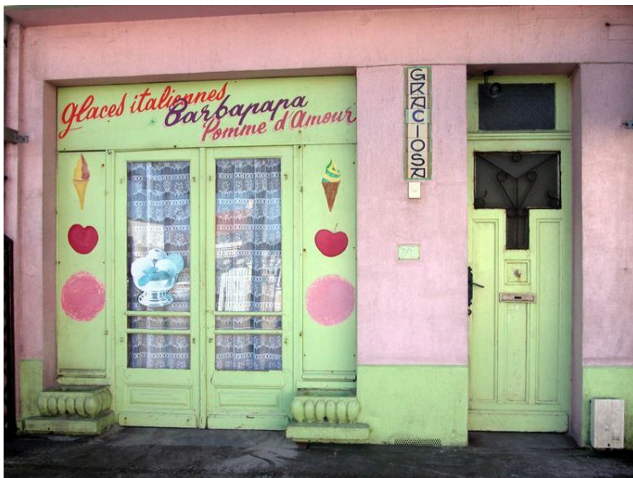
Détail de l'élévation du rez-de-chaussée.
