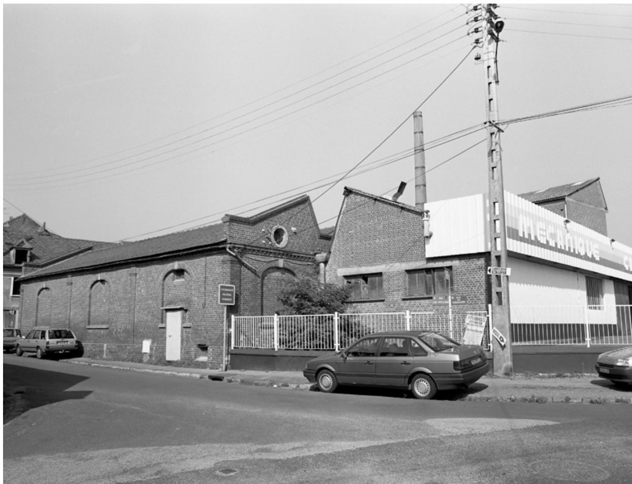
Mur ouest de l'atelier de fabrication.
