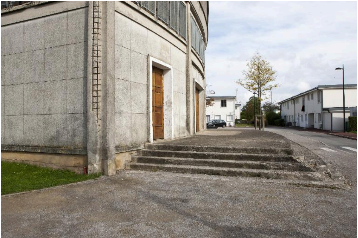
Vue de profil des escaliers menant au porche de l'église, sur la façade antérieure.
