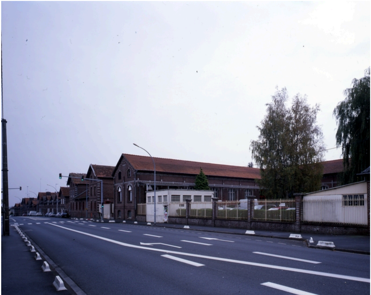
Le site vu depuis la rue de Guise.
