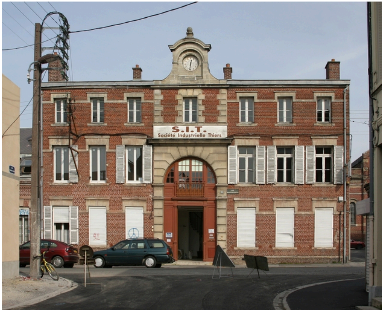
Façade antérieure du logement de directeur et des premiers bureaux.
