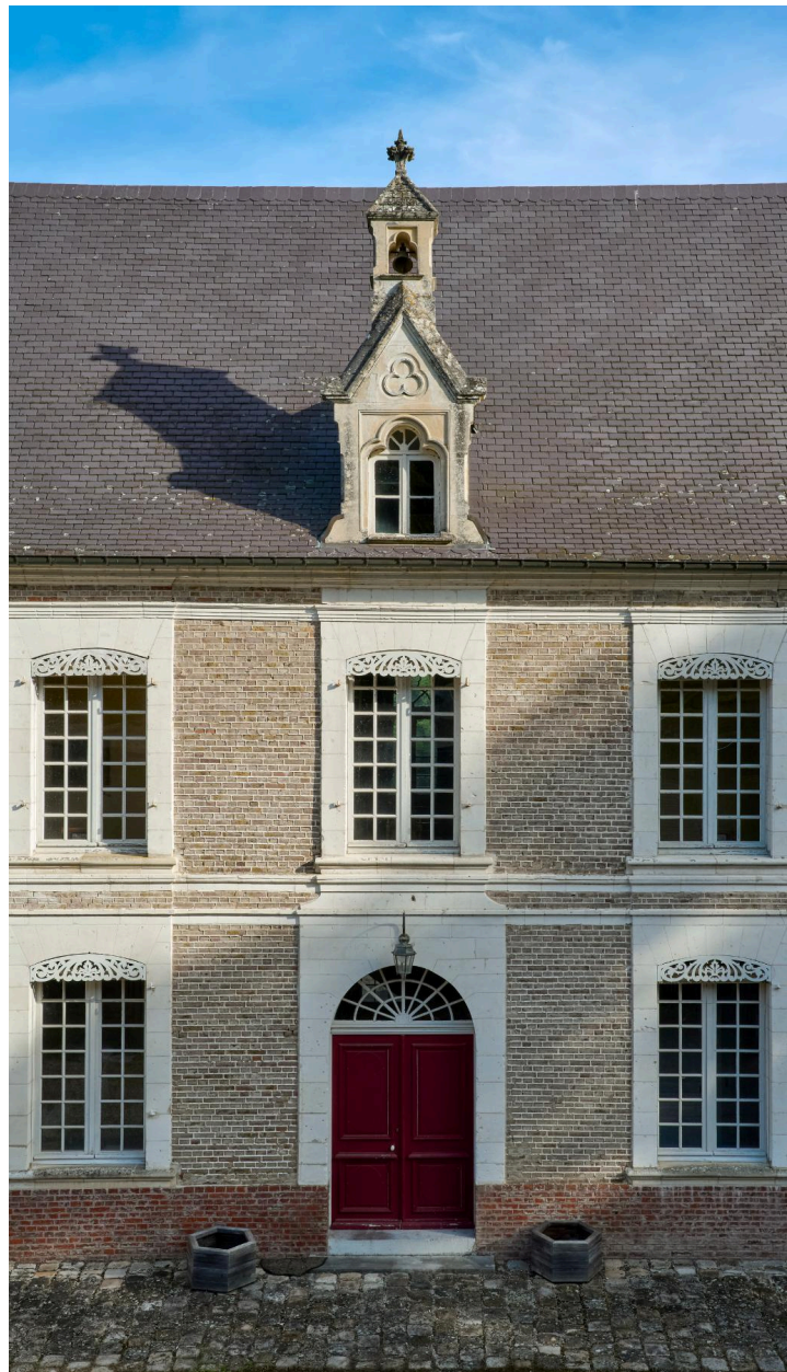
Travée centrale de l'élévation sud.
