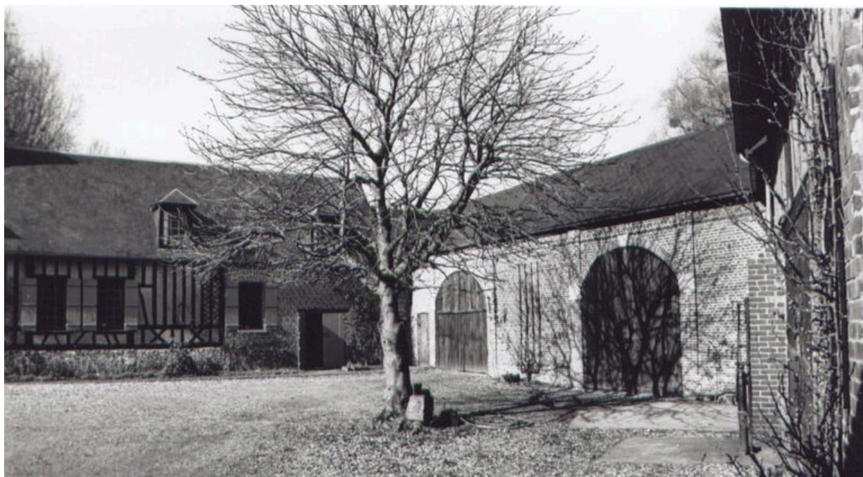
Vue de l'habitation et des granges en retour, façades sur cour.
