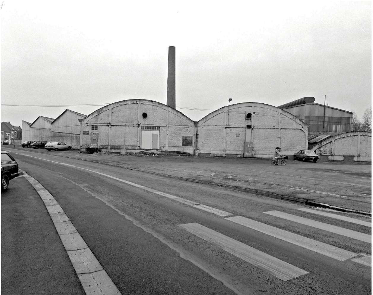
Vue générale prise vers le sud.
