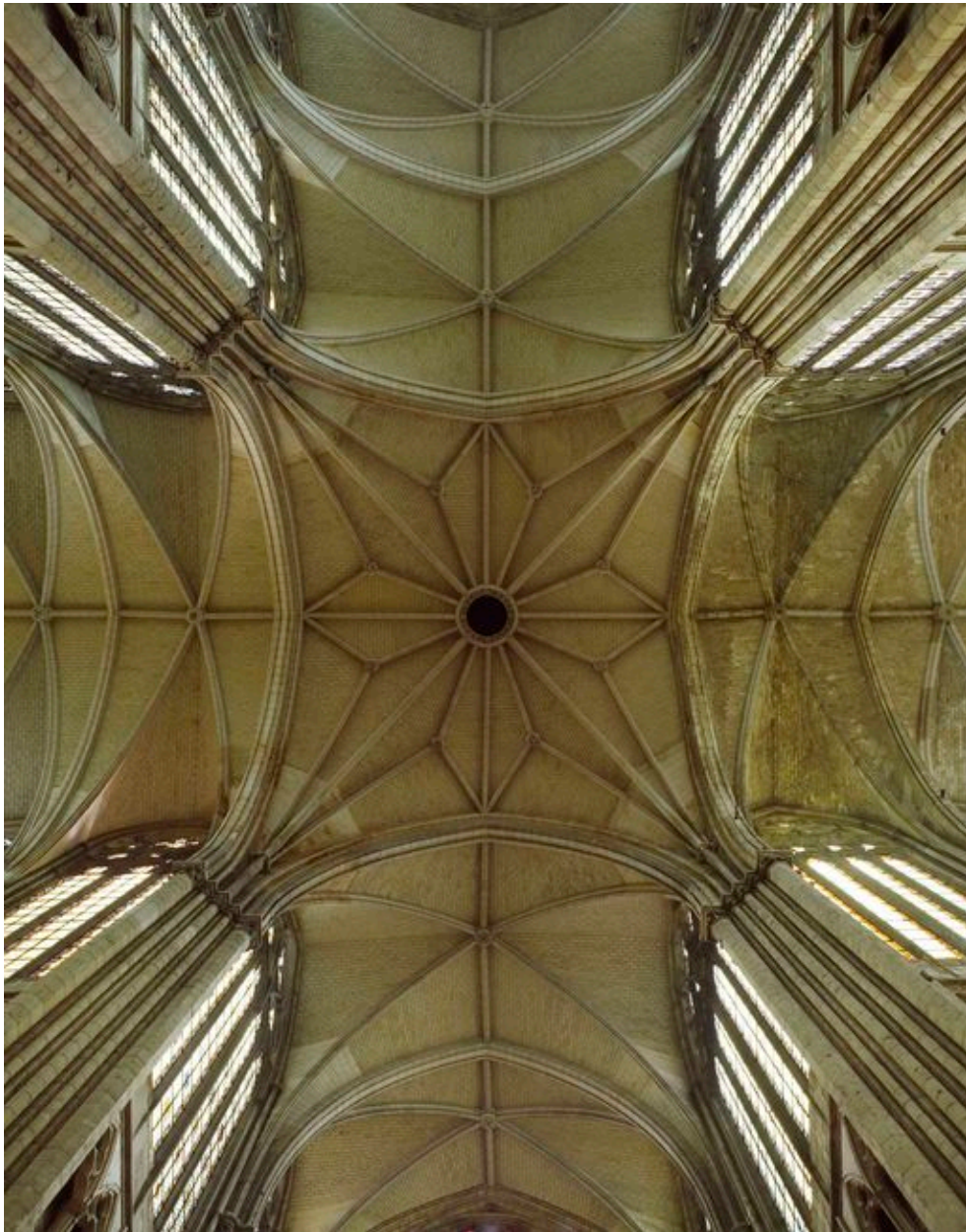
Vue de la voûte de la croisée du grand transept.
