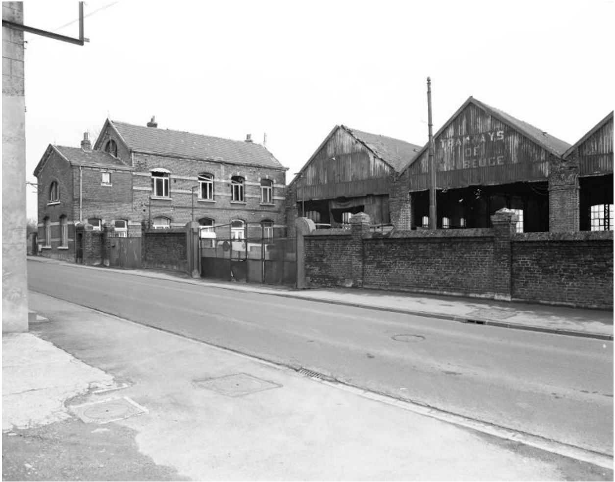
Vue générale depuis la rue, les bureaux et les hangars, prise vers l'est.
