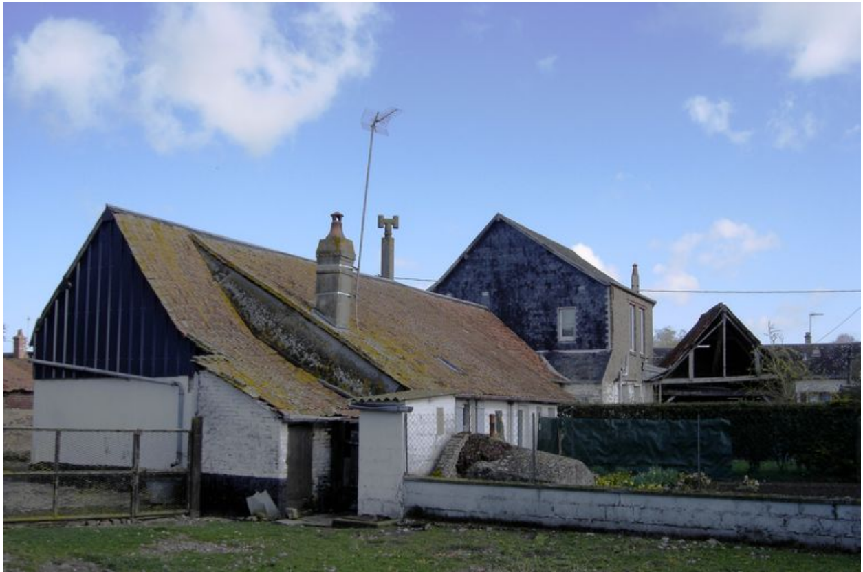
Vue postérieure du logis.
