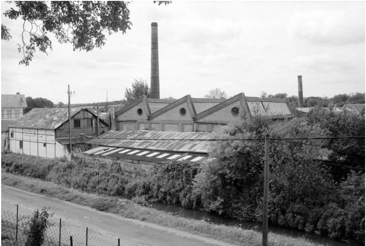
Vue partielle, flanc sud-est.
