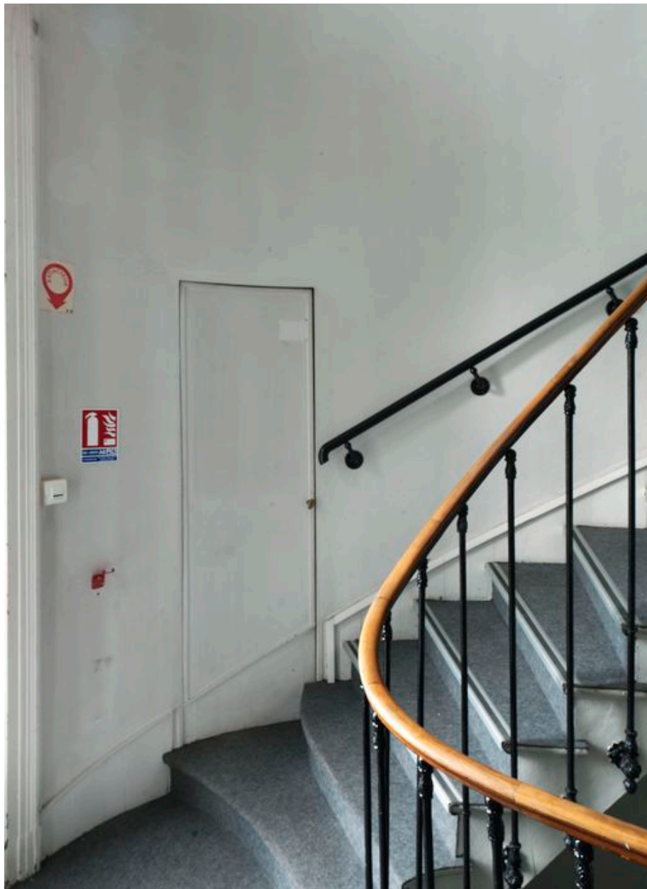
Porte des anciennes latrines accessibles depuis l'escalier principal.
