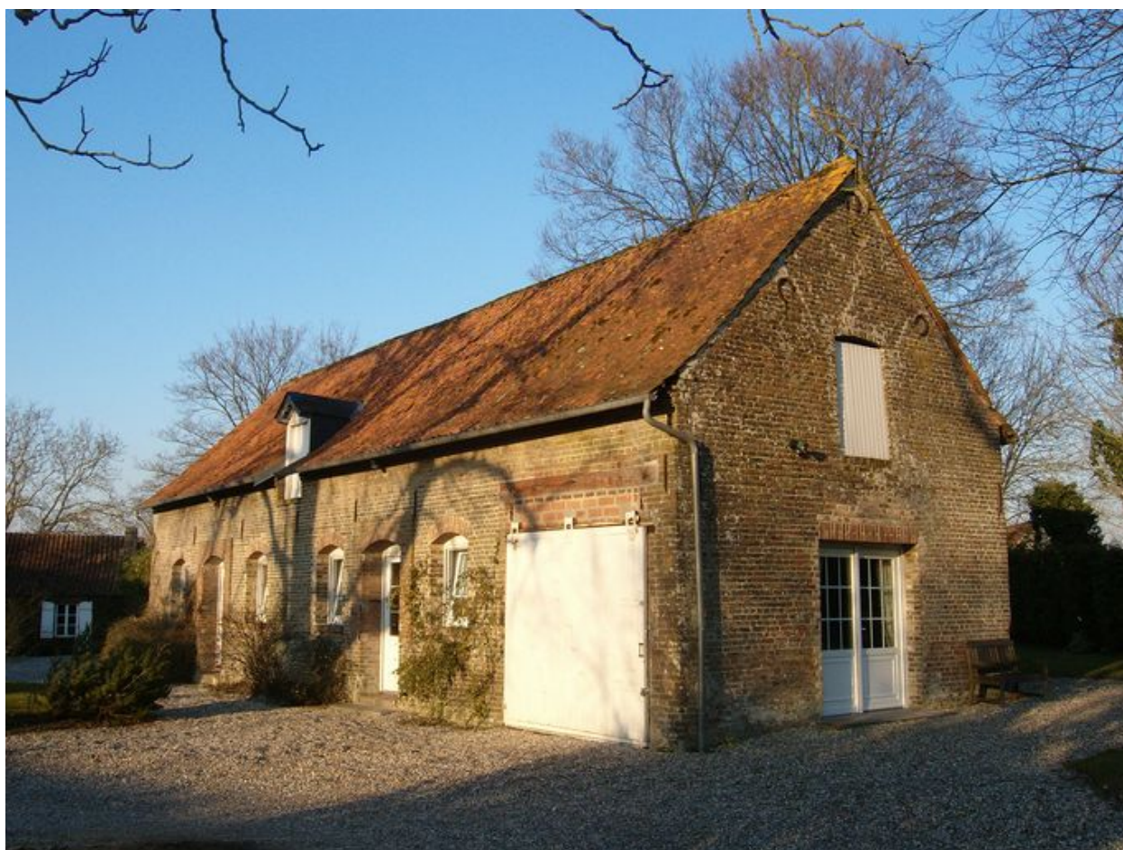
Vue latérale de la grange.
