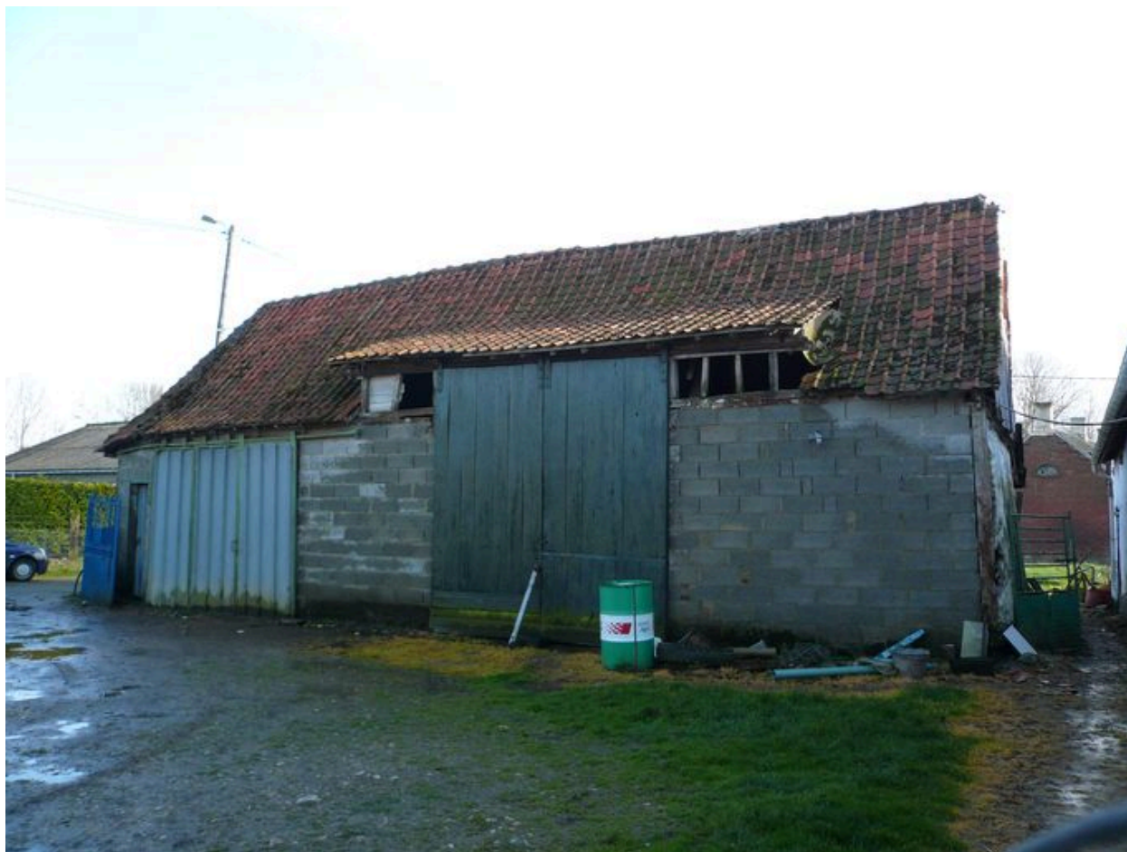
Vue de la grange.
