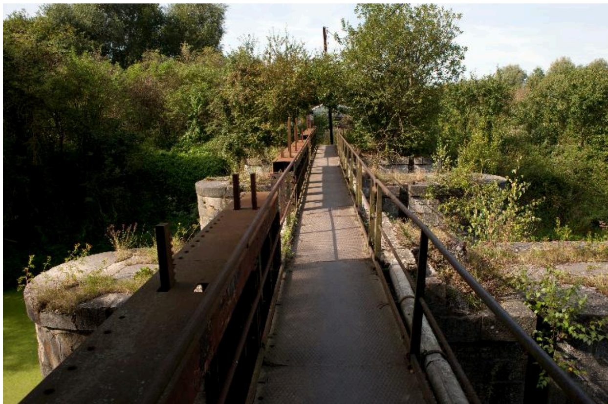
Vue générale de l'écluse de Rodignies.
