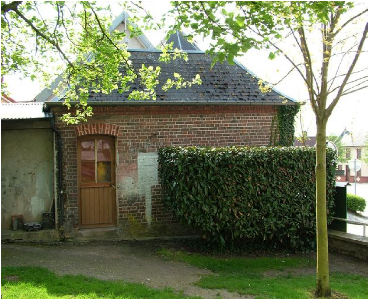
Ancienne remise de matériel d'incendie.
