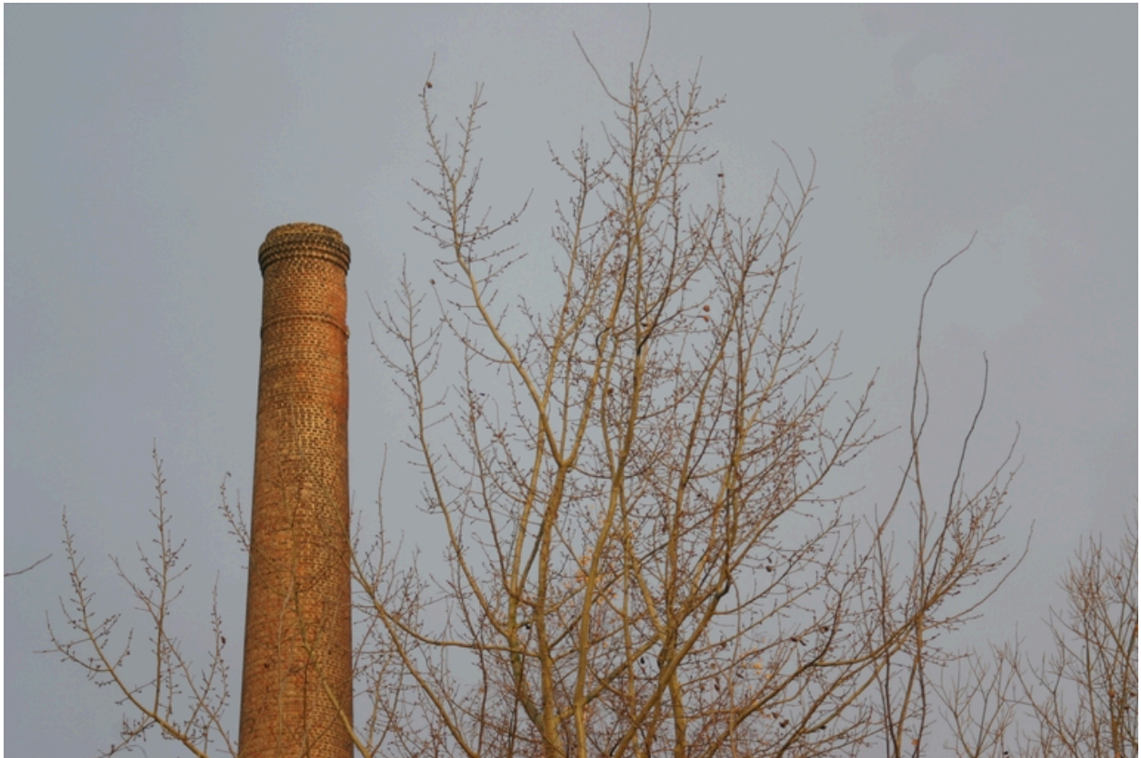
Partie haute du fût de la cheminée et couronnement.
