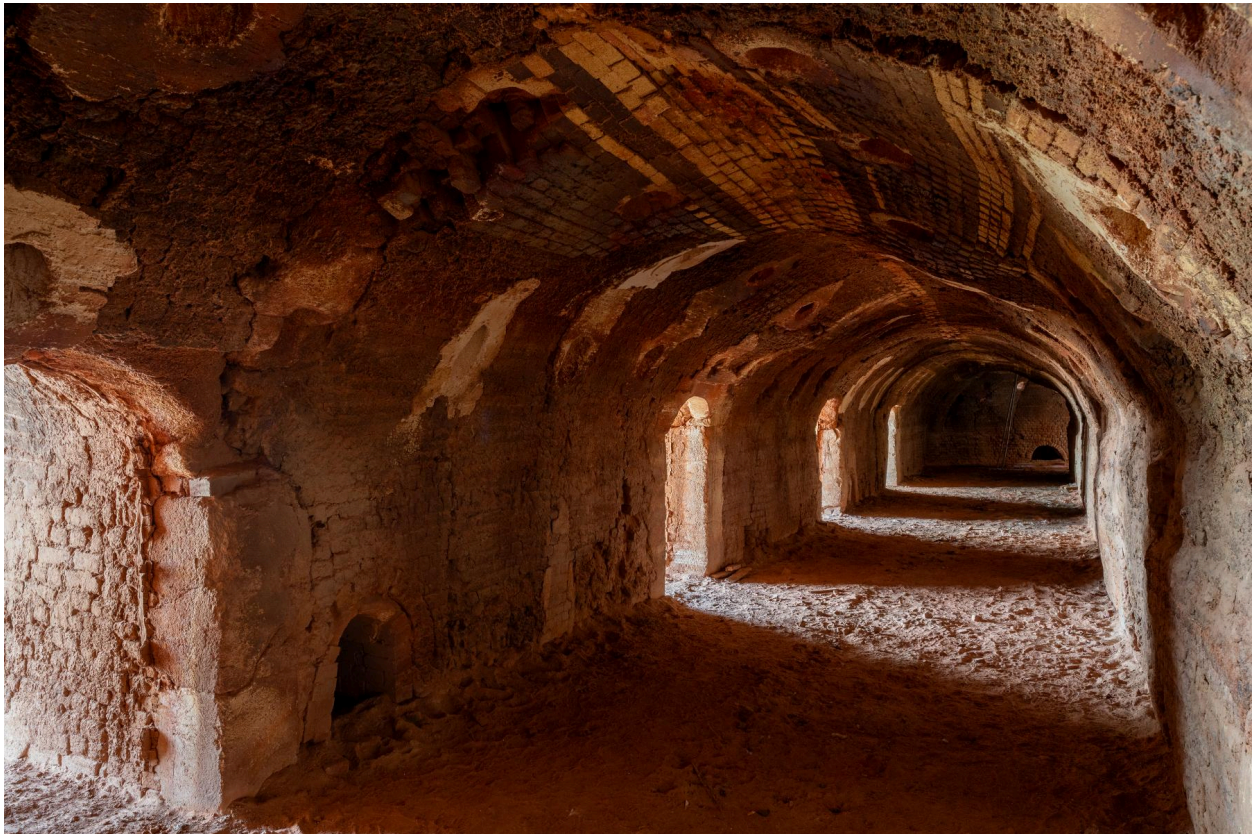
Four Hoffmann. Galerie de cuisson des briques.
