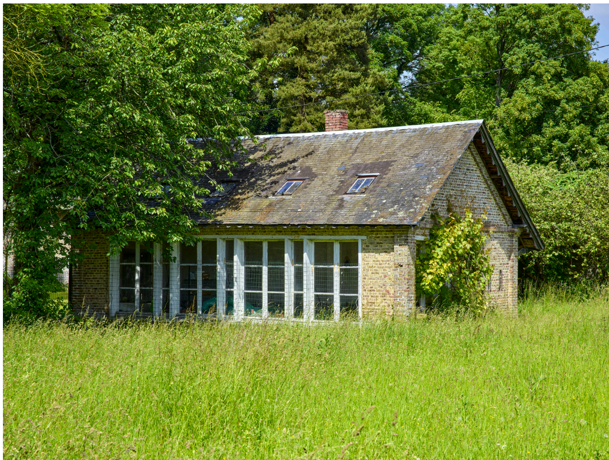
Ancienne serre, depuis le sud-ouest.
