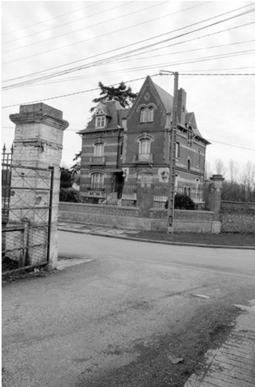
Logement patronal, élévation antérieure.
