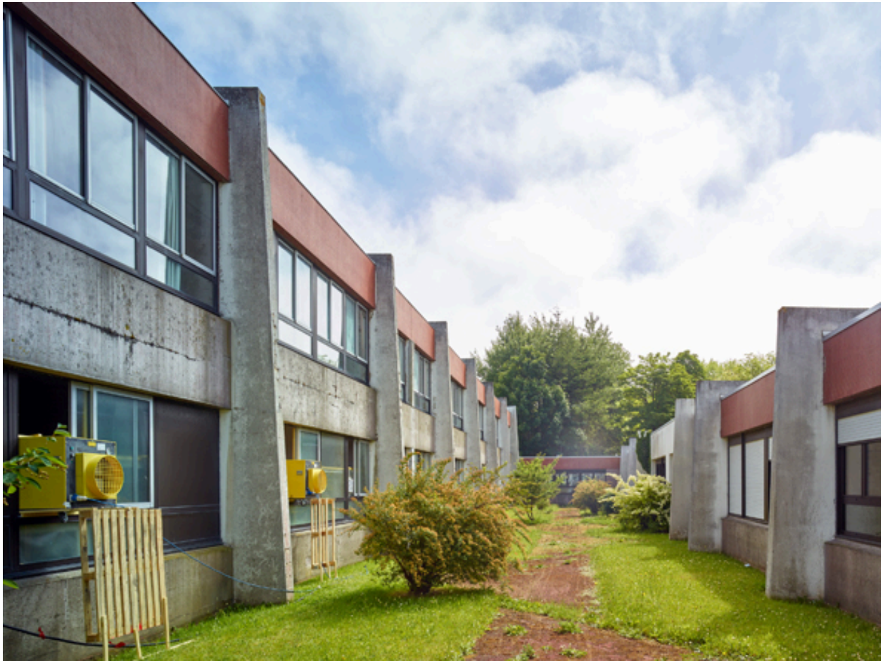
Vue générale du patio central sud ouest, depuis la liaison entre le C.E.S. et le C.E.T.
