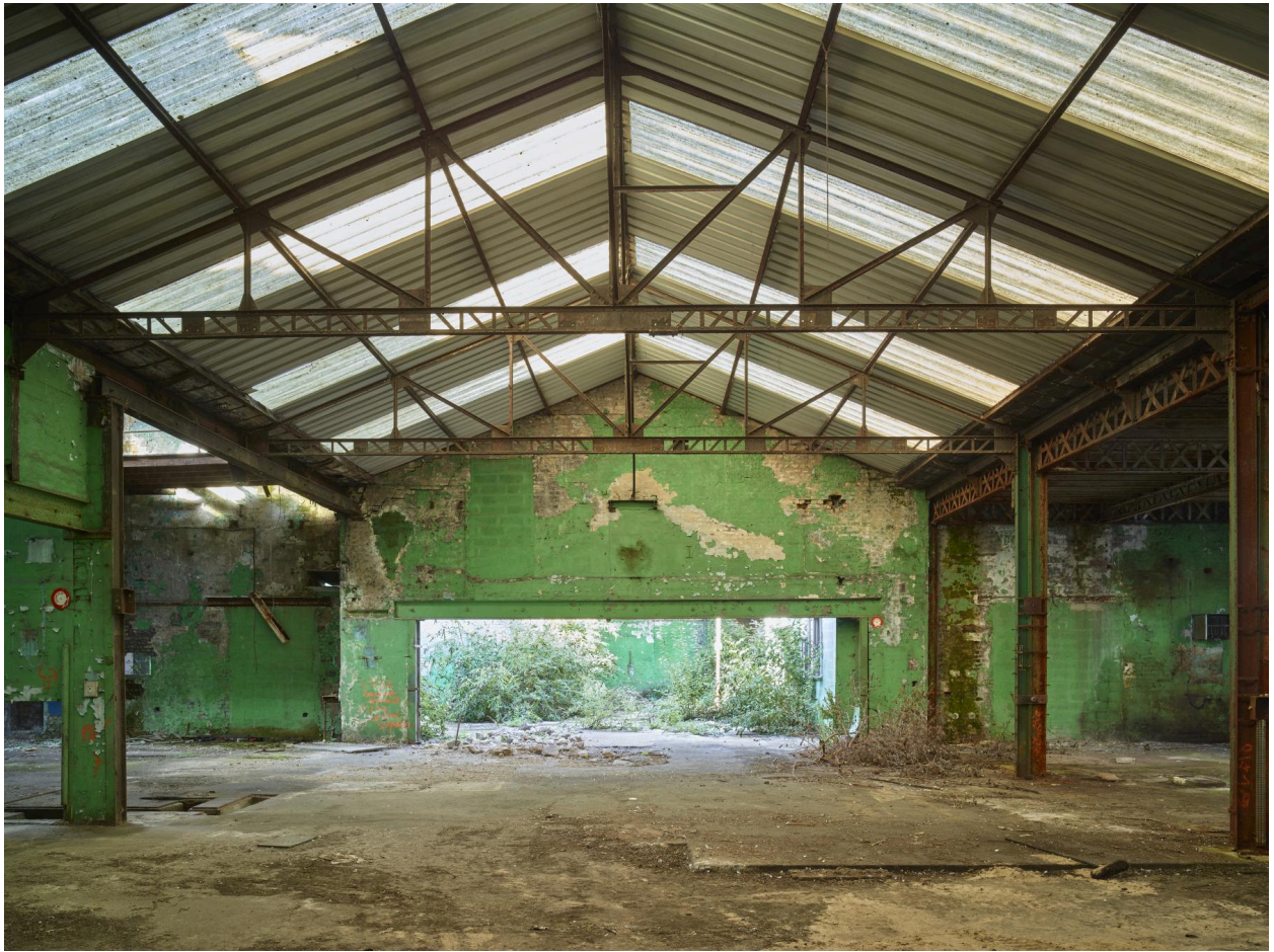
Vue intérieure, vers le sud-ouest, de l'atelier de fabrication ouvrant place de l'Europe.
