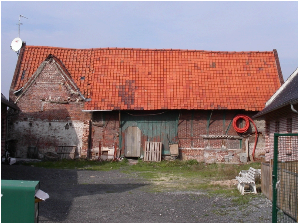
Grange de ferme remaniée (vestige de pan de bois) 1337, rue du Hennoy, vue depuis la rue.
