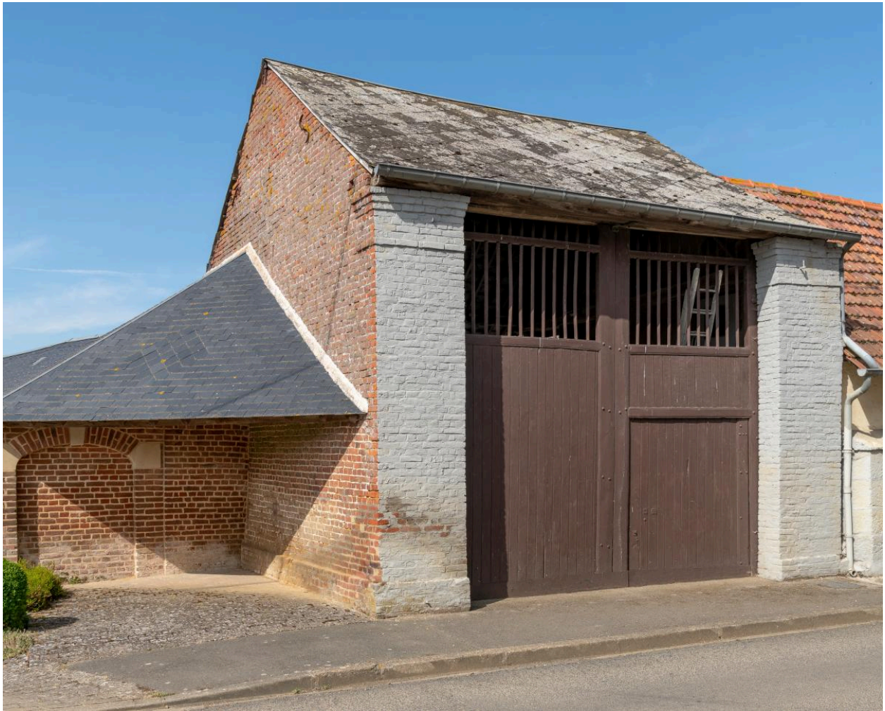
Entrée charretière avec porte monumentale, n°15 rue des Bonhommes, vue depuis l'est.
