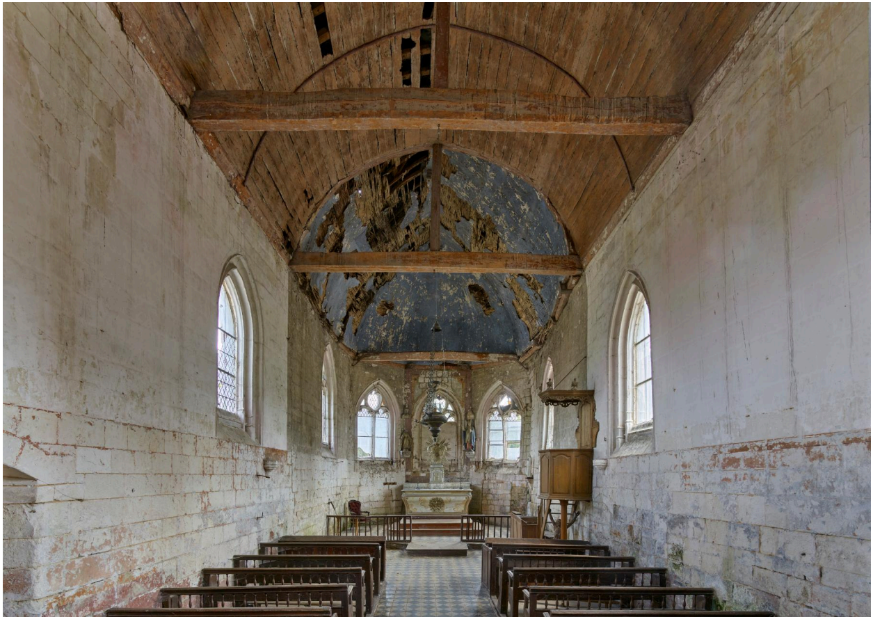
Vue intérieure vers le chœur à l'est.
