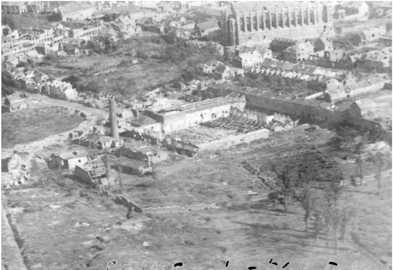
Vue aérienne de la filature, 1918 (AC Saint-Quentin).
