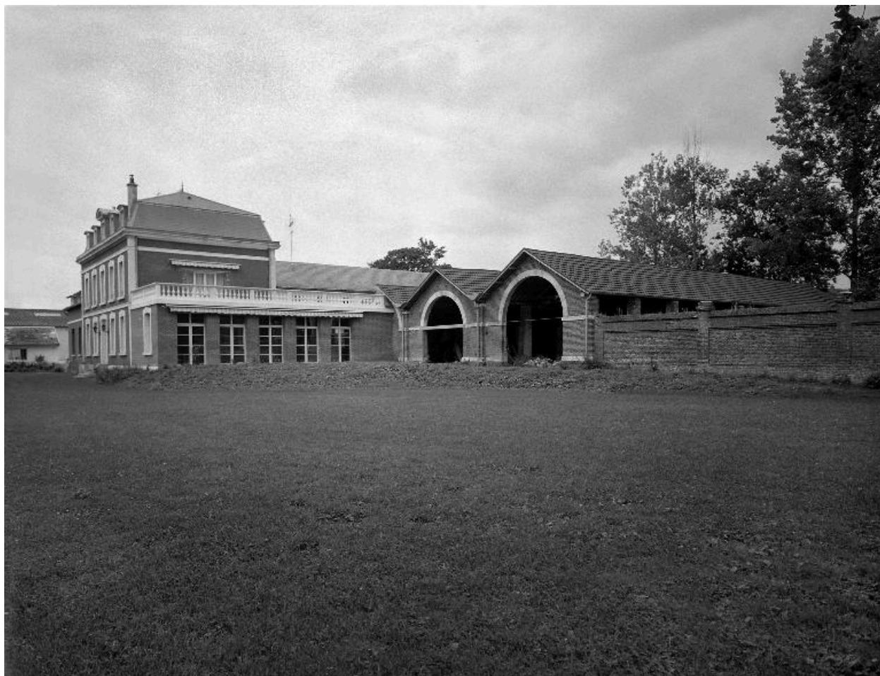
Logement patronal, magasin industriel. Elévation ouest.
