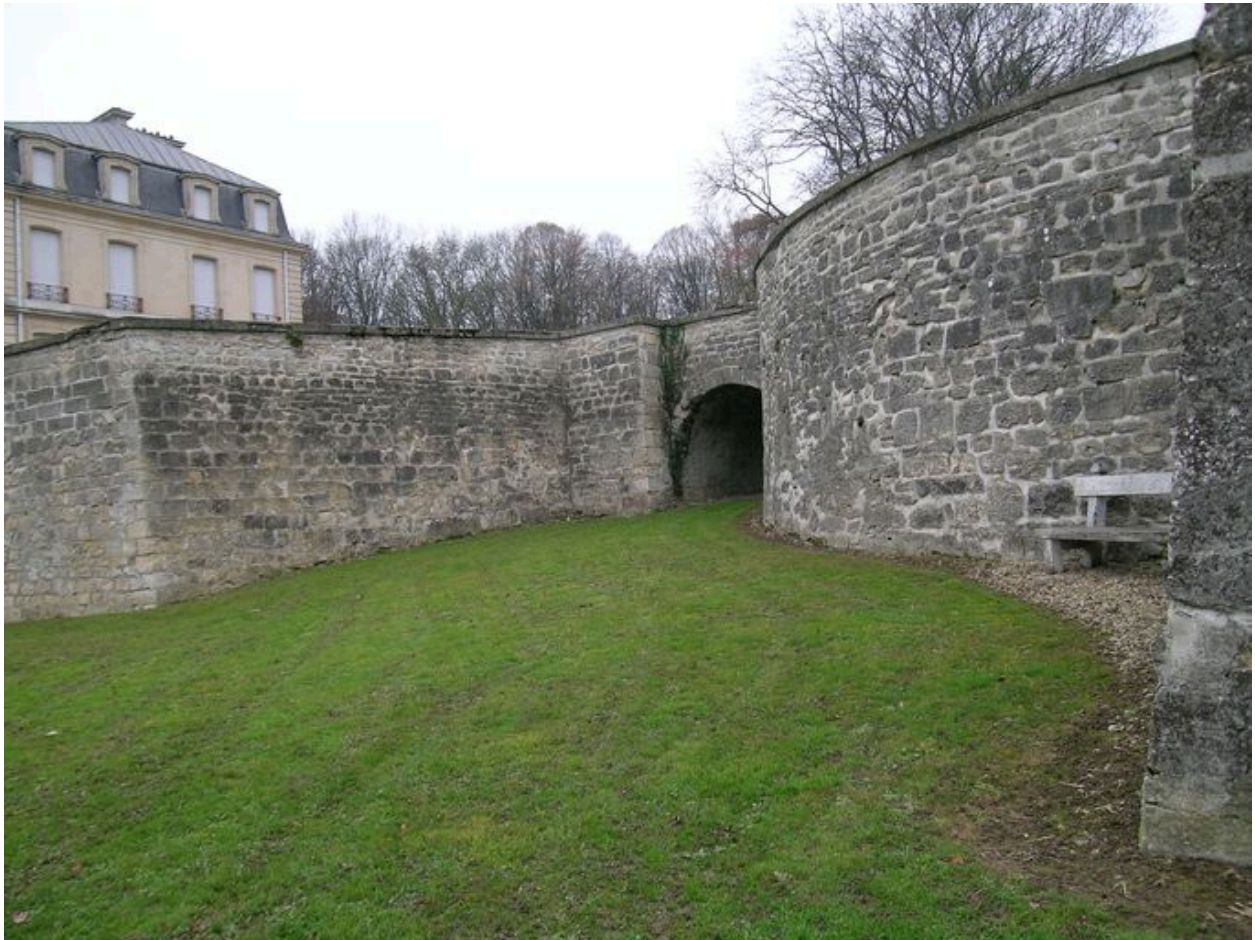
Soubassement de la terrasse percé d'un passage
