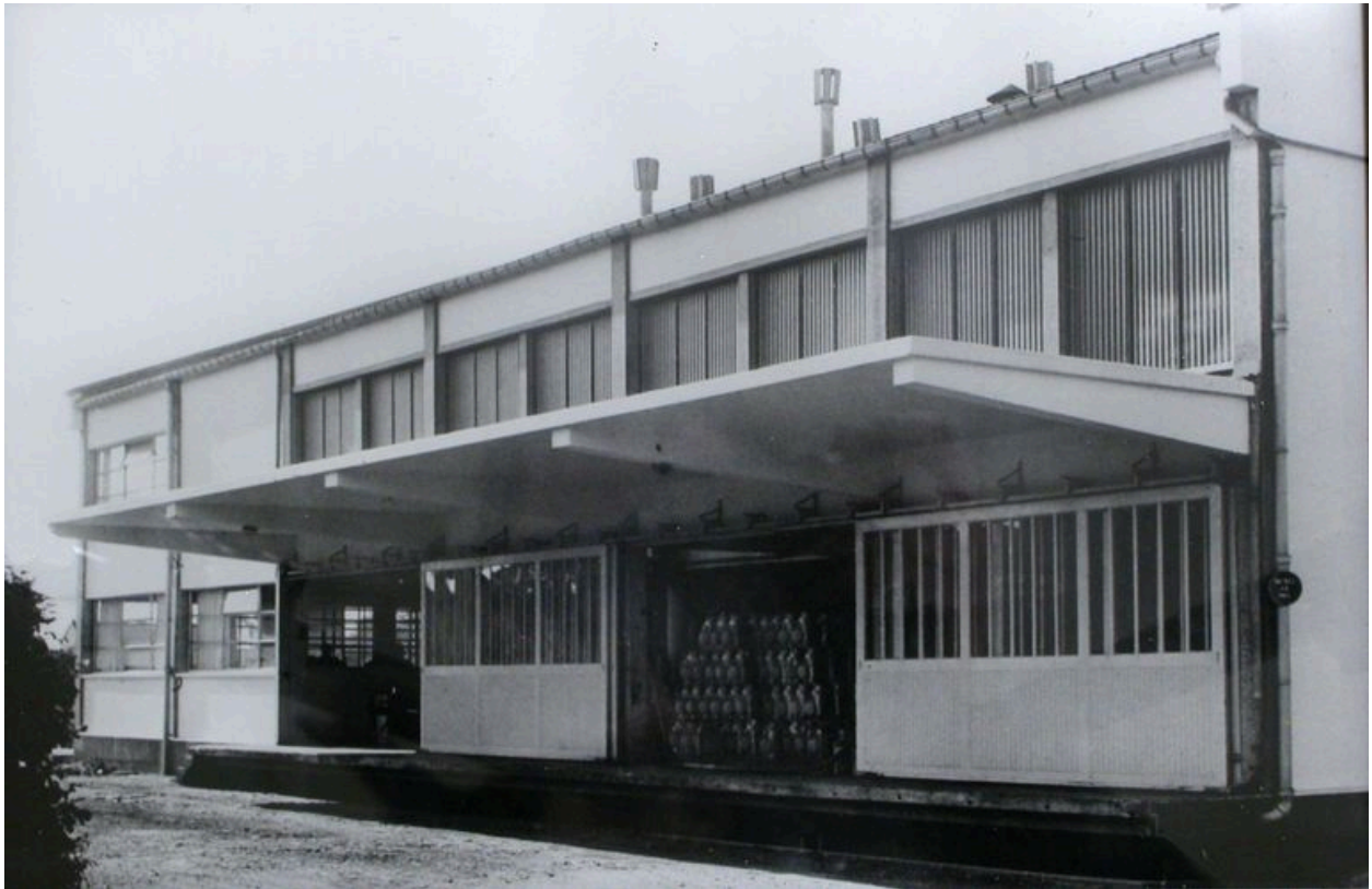
Façade sur cour de la laiterie vers 1960 (Coll. part.).
